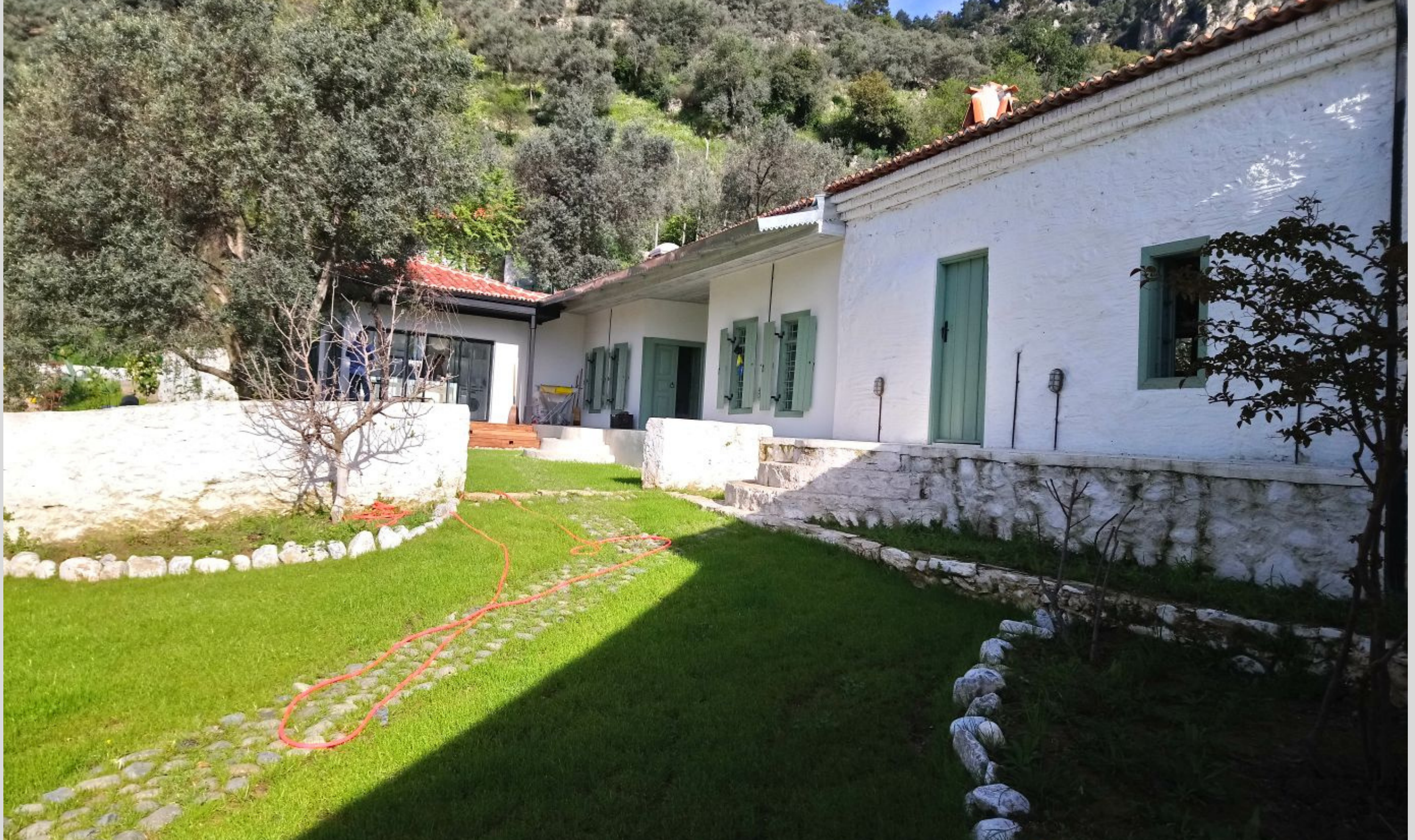
İDİL-EMRE BALKESER KÖY EVİ RESTORASYON - AKYAKA
