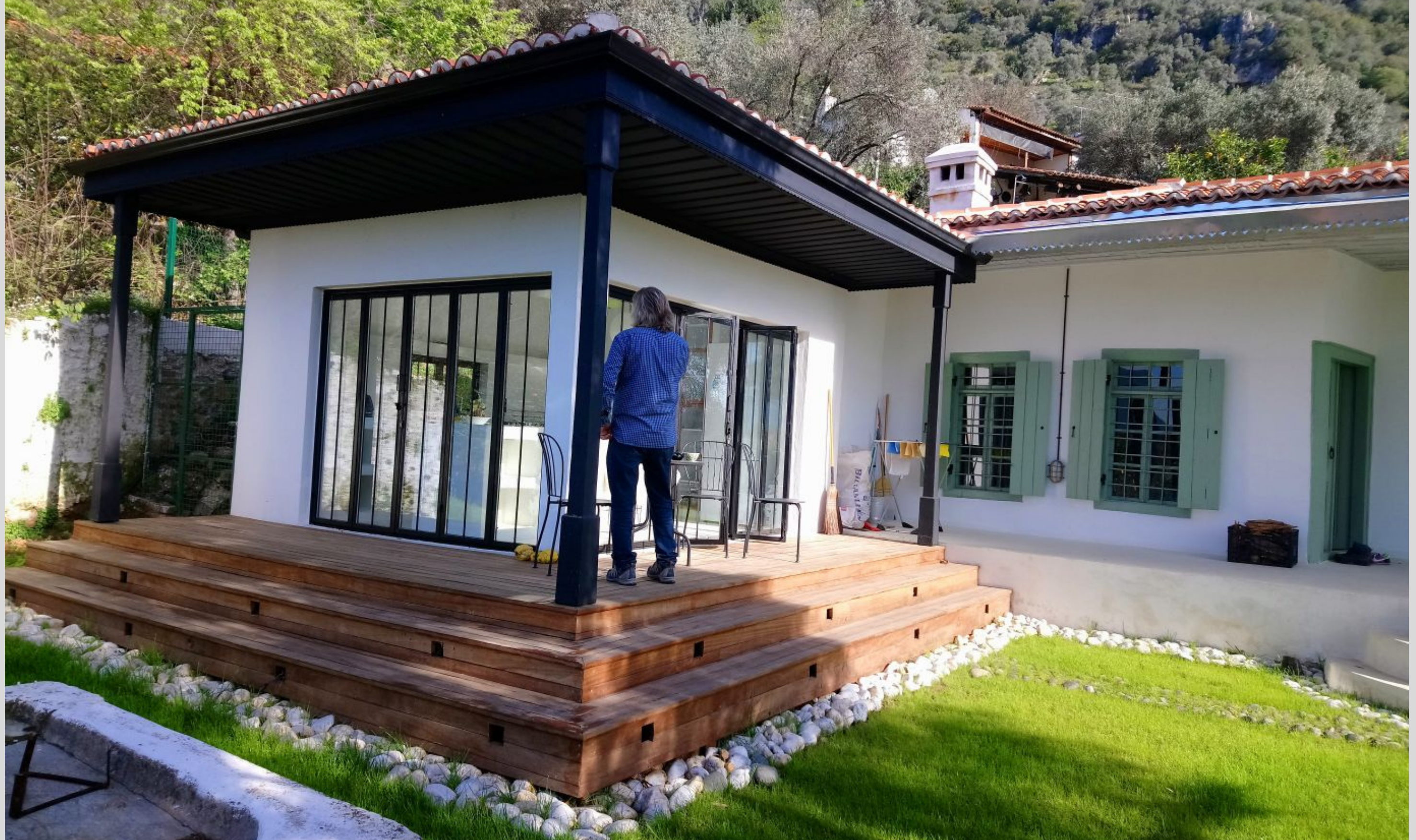
İDİL-EMRE BALKESER KÖY EVİ RESTORASYON - AKYAKA
